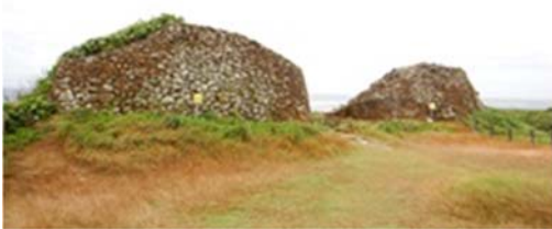
図3 琉球石灰岩を積み上げた城門
