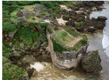
図7 崩落した南端(右下の岩) (ドローン空中撮影)
