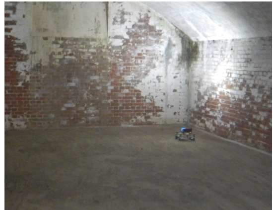
図12 砲側弾薬庫内を走行中
