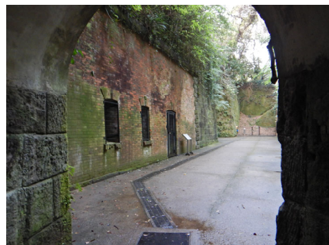
図4 整備し公開されている猿島砲台跡
