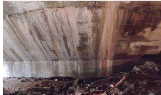
図11 UAVから撮影した壁面
