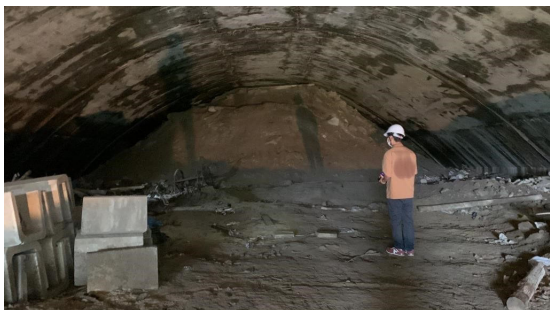
図3 西口坑門（上：外部、中：内部、 下：奥部）
