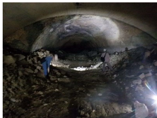
図2 東口坑門（上：外部、中上：内部、中下：奥部、下：素掘り区間）
