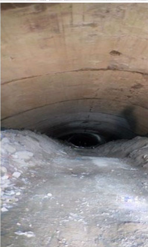
図10 「野島掩体壕」 東入口付近のコンクリート壁区間
