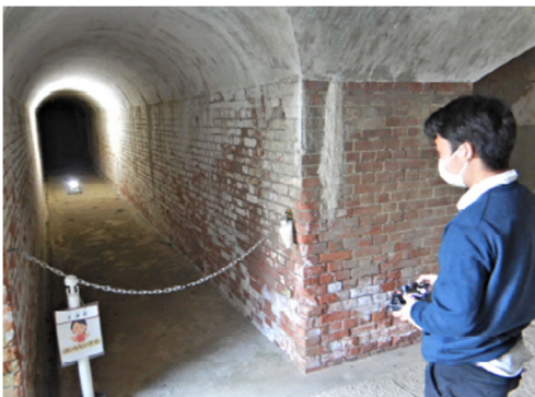
図 14 「千代ヶ崎砲台跡」地下通路
