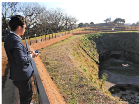
図 13 「千代ヶ崎砲台跡」砲座口縁部
