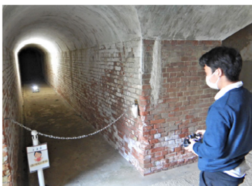
図 14 「千代ヶ崎砲台跡」地下通路
